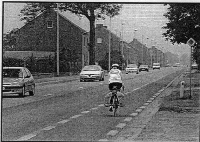
รูปที่ 2.2 แสดงเส้นทางจักรยานแบบ Shared Paths
