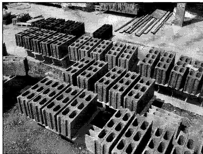
รูป ข.14 ส่วนผสมที่ถูกอัดขึ้นรูปเป็นอิฐบล็อกก่อผนังถอดแบบ และทิ้งไว้ให้แห้งเป็นเวลา 12 ชั่วโมง
