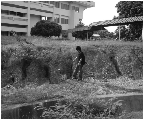
ภาพที่ 1 คันดินที่ถูกกัดเซาะอย่างรุนแรงในบริเวณมหาวิทยาลัย เทคโนโลยีสุรนารี
