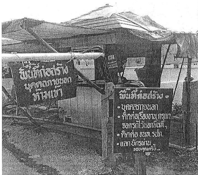
รูปที่ 4.11 ความปลอดภัยในการทำงานก่อสร้างว่าด้วยเขตก่อสร้างโครงการก่อสร้างที่ 4
