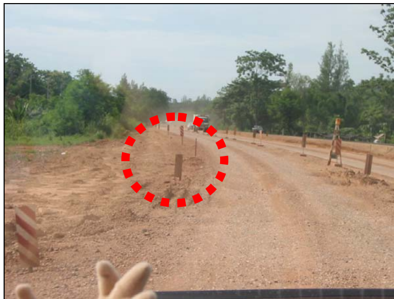
รูปที่ 4.7 สภาพอุปกรณ์ในการจัดการช่องจราจรเสื่อมสภาพ ไม่ได้มาตรฐาน
