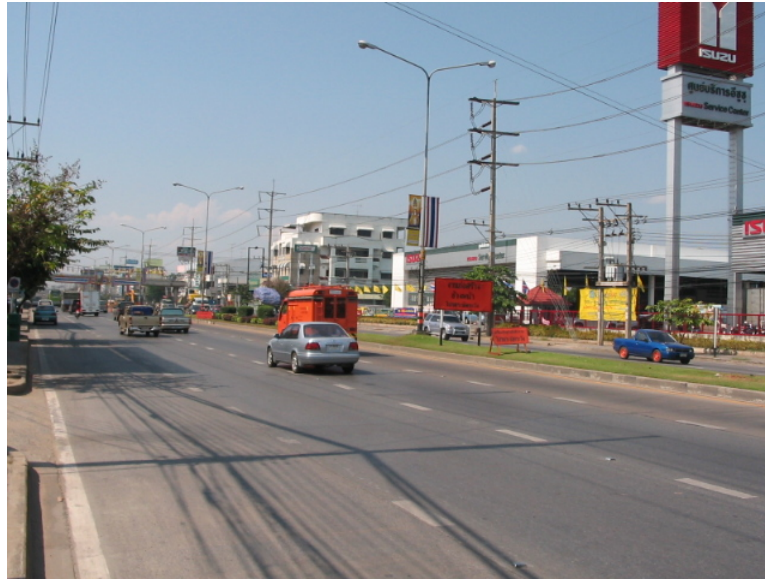
รูปที่ 4.17 ขาดการควบคุมจัดการจำกัดความเร็วก่อนเข้าสู่บริเวณที่มีกิจกรรมงานทาง
