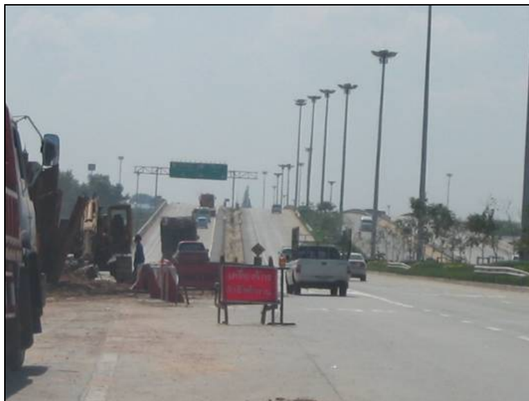
รูปที่ 4.3 การติดตั้งป้ายเตือนบริเวณที่มีกิจกรรมงานทางขาดความต่อเนื่อง
