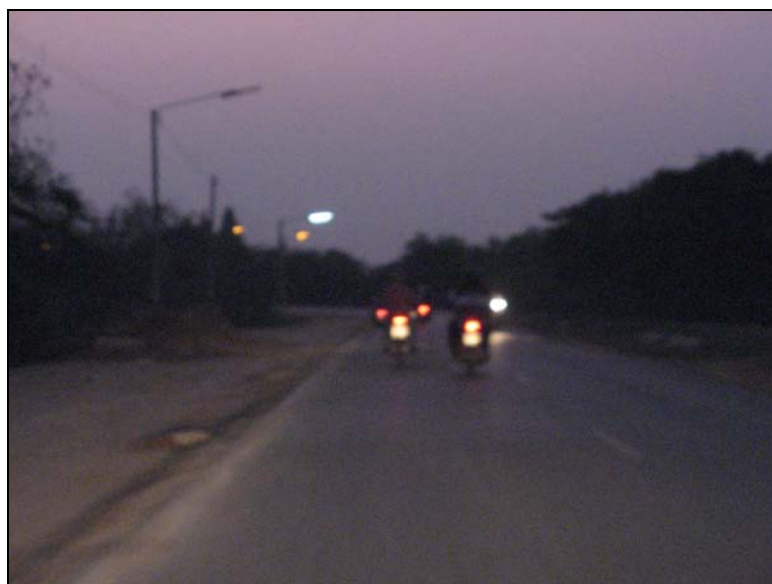
รูปที่ 4.14 สภาพการส่องสว่างบริเวณข้างทางไม่เพียงพอ
