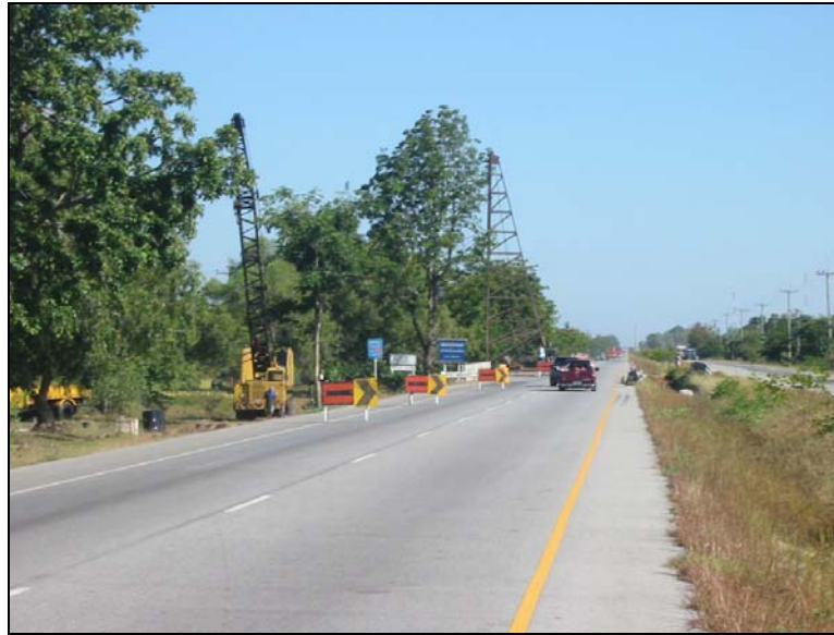
รูปที่ 4.5 ตำแหน่งติดตั้ง การสื่อความหมาย การบอกทิศทางของป้ายเตือนไม่เหมาะสม
