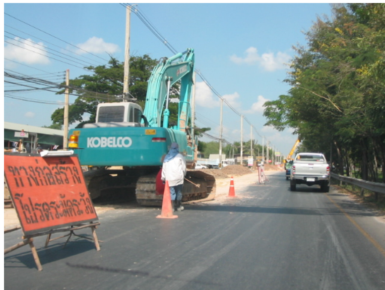
รูปที่ 4.18 ป้ายสัญญาณในการควบคุมการจราจรไม่สามารถมองเห็นได้อย่างชัดเจน
