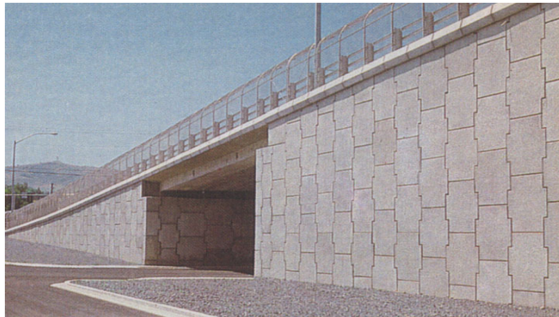
รูปที่ 2.1 การก่อสร้างกำแพงกันดินที่ปราศจาก Berm และ Side slope
