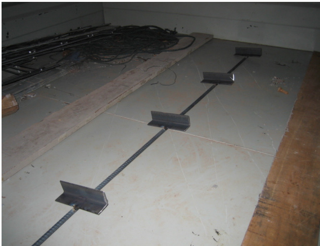
รูปที่ 3.5 ส่วนประกอบของเหล็กเสริมรับแรงแบกทาน
