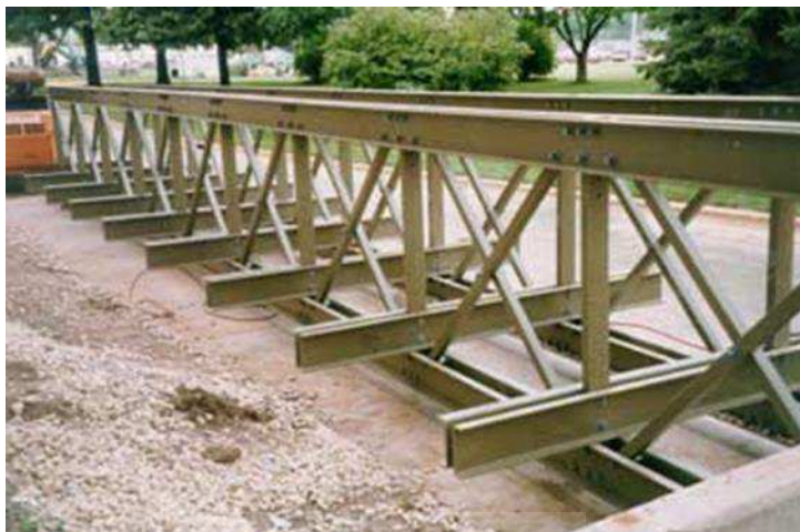
รูปที่ 1.5 สะพานที่ประกอบขึ้นจากชิ้นส่วน FRP (United States Department of Agriculture, 1997)
