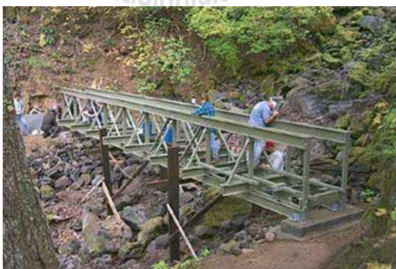
รูปที่ 1.6 การนำสะพานที่ประกอบขึ้นจากชิ้นส่วน FRP ไปใช้ในพื้นที่ ๆ เข้าถึงยาก (United States Department of Agriculture, 1997)
