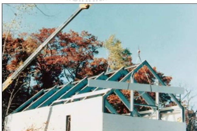
รูปที่ 2.7 การติดตั้ง โครงสร้างข้อแข็งที่ทำจากวัสดุ PFRP ระหว่างการก่อสร้าง (Strongwell, 2002)
