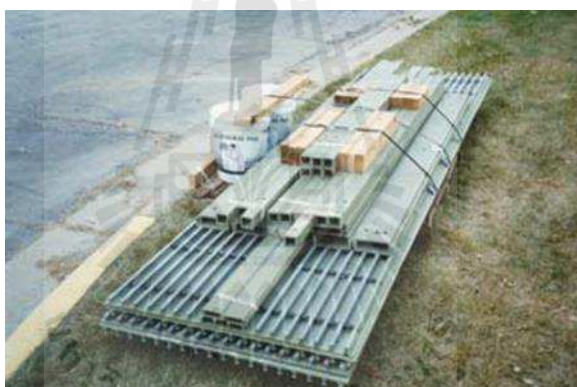
รูปที่ 1.5 สะพานที่ประกอบขึ้นจากชิ้นส่วน FRP (United States Department of Agriculture, 1997)
