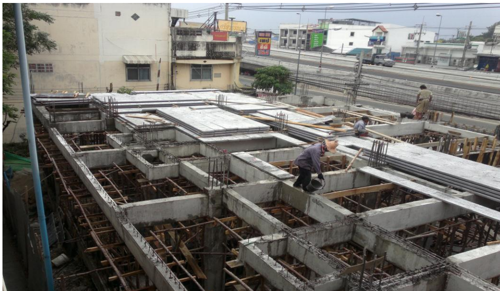
รูปที่ 1.2 อาคารพักอาศัยรวมสูง 4 ชั้น ที่กำลังดำเนินการ
