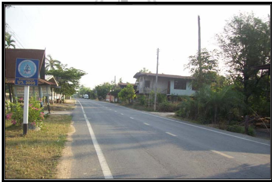
รูปที่ 4.1 ถนนถนนลาดยางสายบ้านหัวฝ้าย - นาลาว หมายเลข 3005 ที่ จะทำการติดตั้งเฉพาะ ดวงโคมไฟฟ้าแสงสว่างสาธารณะพร้อมพาดสายอลูมิเนียม
