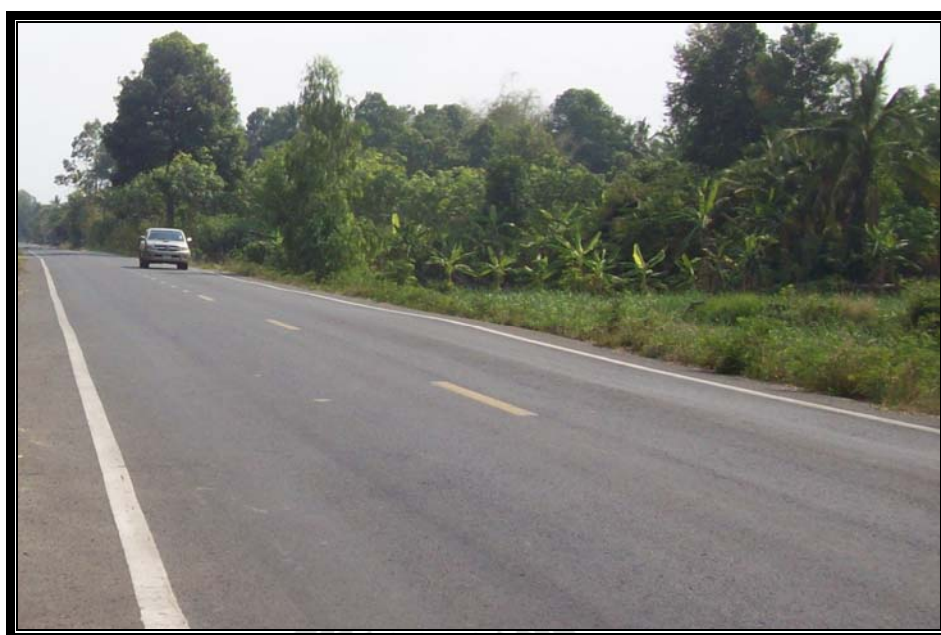
รูปที่ 4.2 ถนนลาดยางสายบ้านหัวฝาย - นาลาว หมายเลข 3005 ที่จะทำการขยายเขตไฟฟ้าแรงต่ำ และติดตั้งโคมไฟฟ้าแสงสว่างสาธารณะ พร้อมสายอลูมิเนียม
