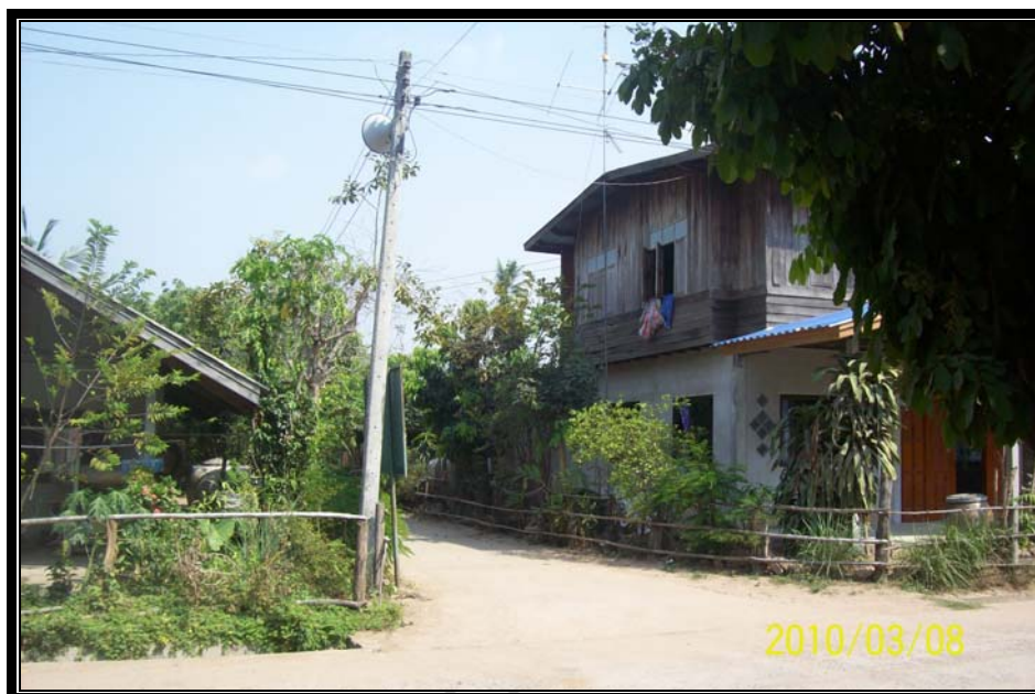
รูปที่ 4.5 ถนนลาดยางสายบ้านหัวฝาย - นาลาว หมายเลข 3005 ที่จะทำการติดตั้งคอมไฟฟ้า แสงสว่างสาธารณะ พร้อมสายอลูมิเนียม
