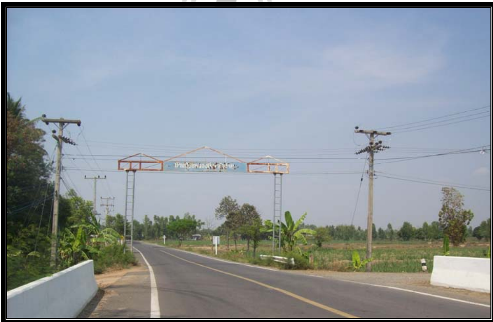
รูปที่ 4.3 ทางแยกจากถนนลาดยางสายบ้านห้วยฝ้าย - นาหลวง หมายเลข 3005 ที่จะทำการติดตั้ง โคมไฟฟ้แสงสว่างสาธารณะ พร้อมสายอลูมิเนียม
