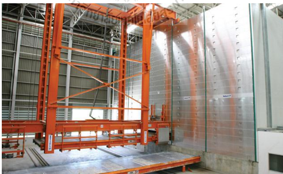
รูปที่ 2.9 การบ่มคอนกรีตด้วยระบบเตาอบ ( Pruksa Real Estate , 2006)
