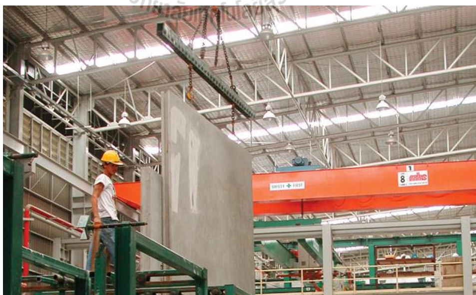
รูปที่ 2.11 การยกชิ้นงาน (Pruksa Real Estate , 2006)
