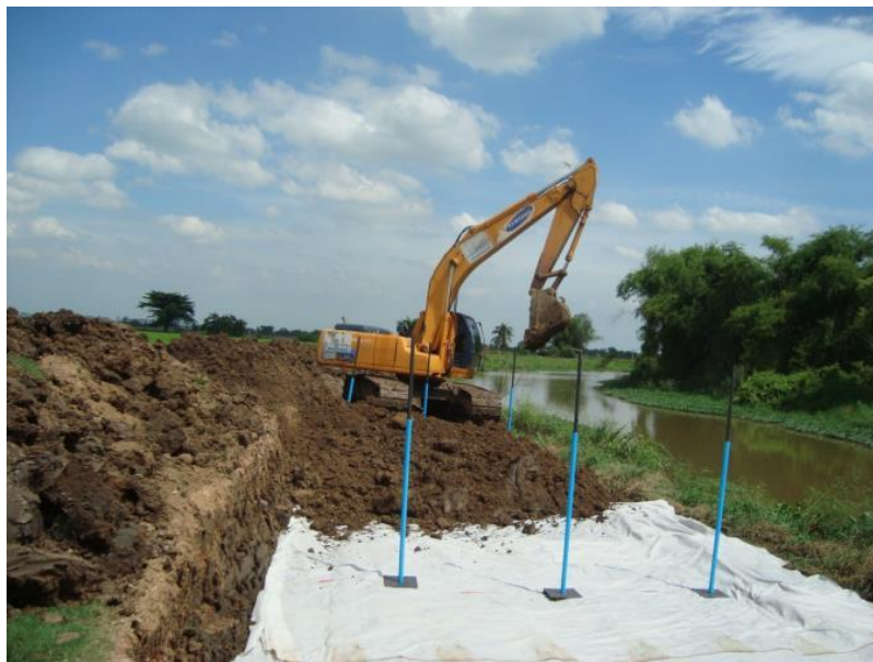
รูปที่ 4.7 การถมคันทางในแปลงทดลองที่ 1 และแปลงทดลองที่ 2 และบดอัด
