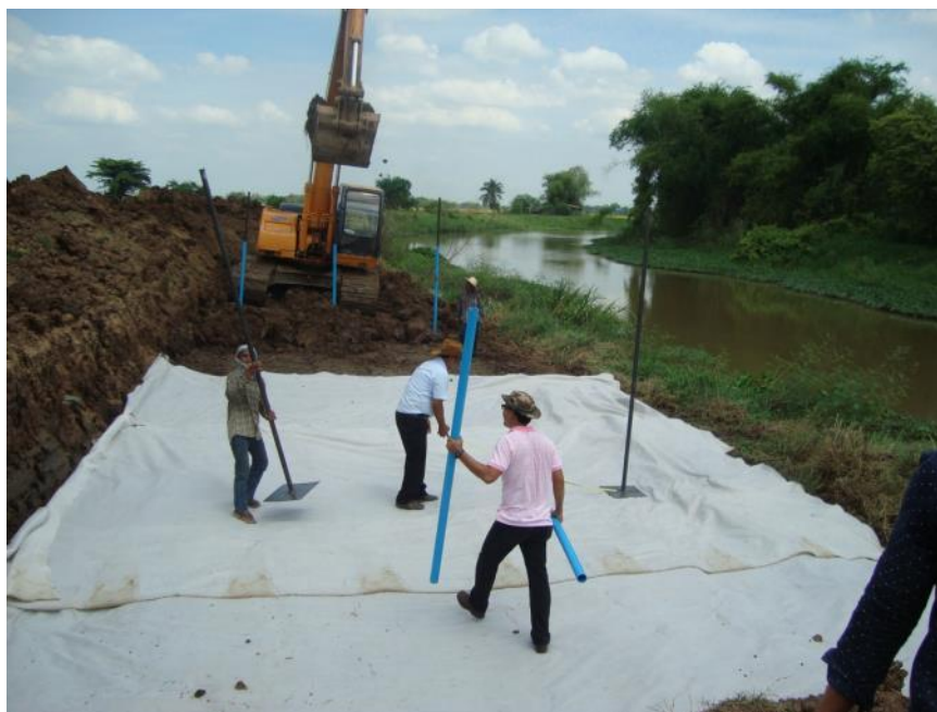
รูปที่ 4.6 การติดตั้งแผ่นทรุดตัวในแปลงทดลองที่ 1
