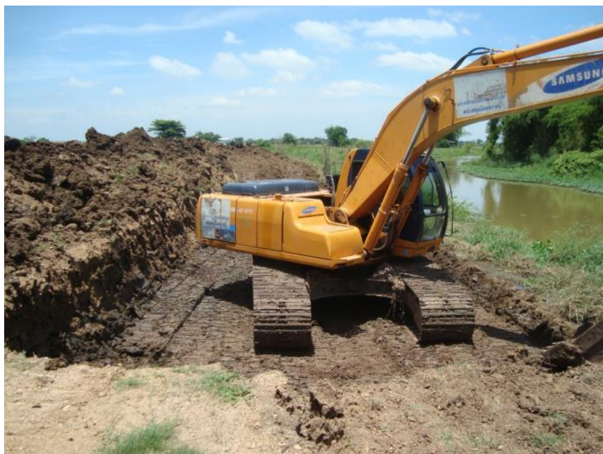
รูปที่ 4.4 ขั้นตอนการก่อสร้างคันทาง
