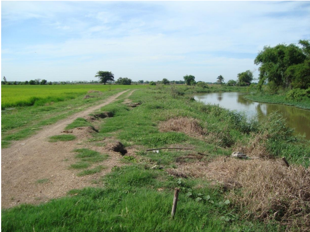
รูปที่ 3.2 ความเสียหายของคันทาง
