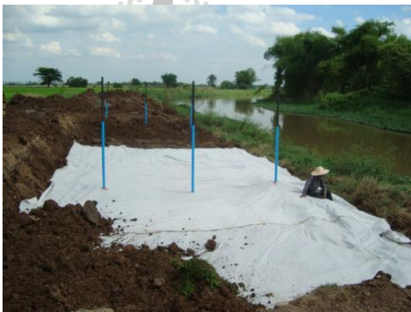
รูปที่ 4.8 การปูแผ่นใยสังเคราะห์ชั้นที่ 2 ในแปลงทดสอบที่ 1
