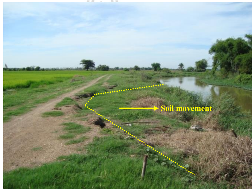
รูปที่ 4.1 การวิบัติของคันดินถมบนดินอ่อนเรียบตลิ่ง
