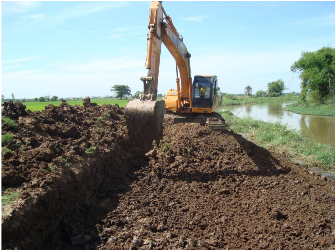
รูปที่ 3.10 ดินถมจากคันทางเดิม
