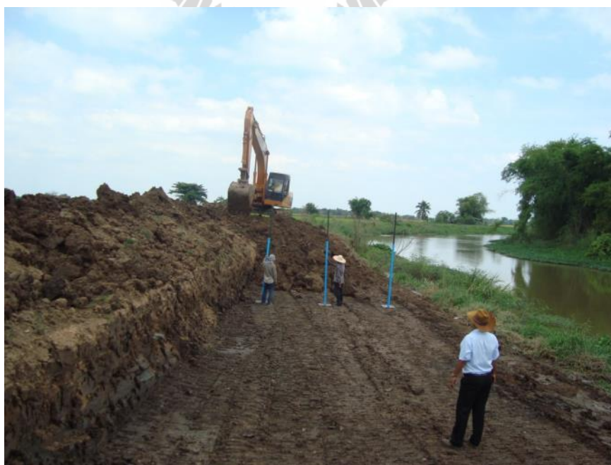
รูปที่ 4.5 การติดตั้งแผ่นทรุดตัวในแปลงทดลองที่ 2
