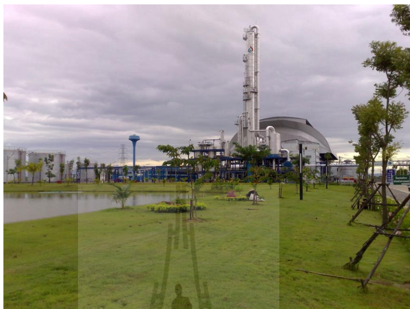
รูปภาพ 14 แสดงหอกลิ้นแบบ cap tray ของโรงงานผลิตไบโอเอทานอลแห่งหนึ่ง
