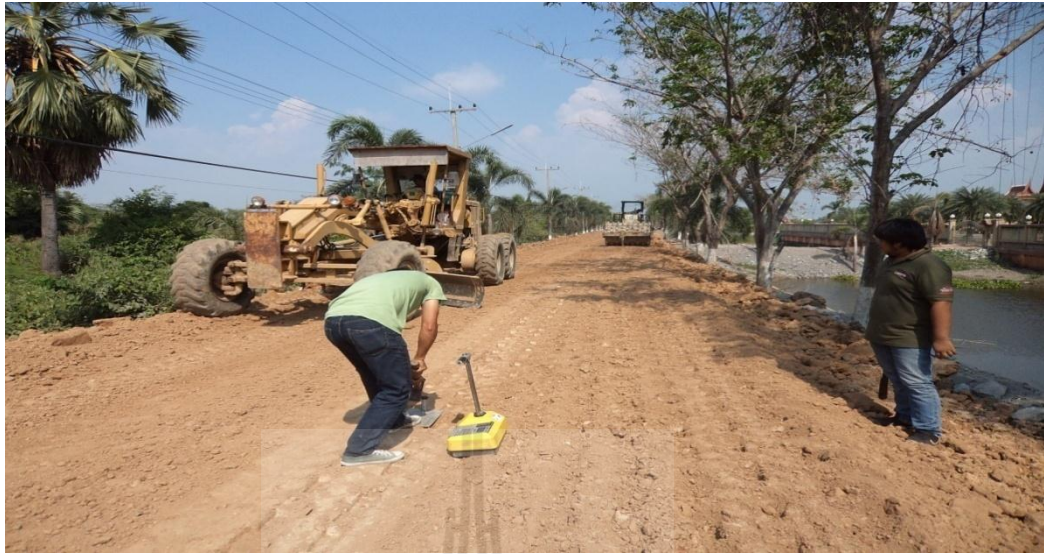
รูปที่ 3.2 การทดสอบความแน่นในสนาม
