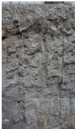
รูปที่ 7 SCC ที่ก่อสร้างต่อเนื่องกัน เห็นรอยต่อระหว่าง SCC แต่ไม่หลุดแยกจากกัน
