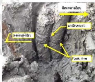
รูปที่ 16 การวิบัติของเสาเข็มที่ก่อสร้างเสร็จที่ระยะห่างกัน 24 ชั่วโมง
