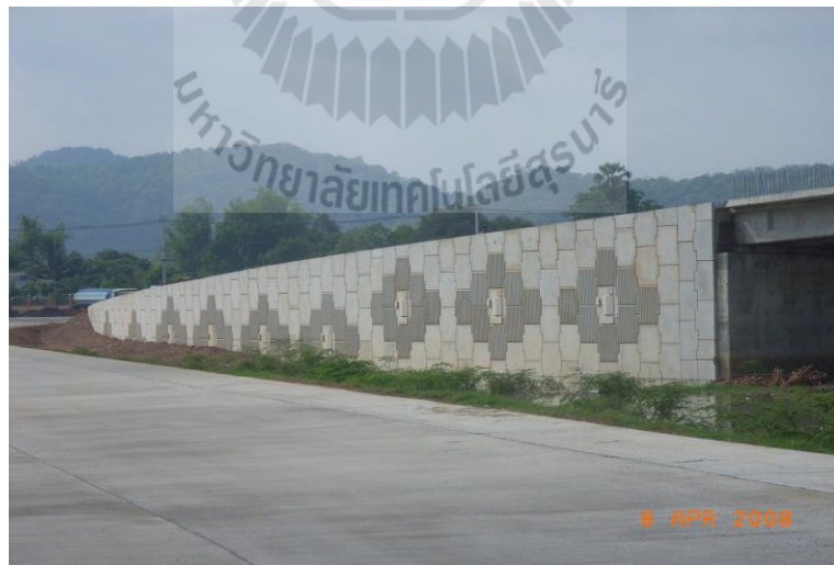
(ข) Facing ของกำแพงกันดินเหล็กเสริมแบกทาน
