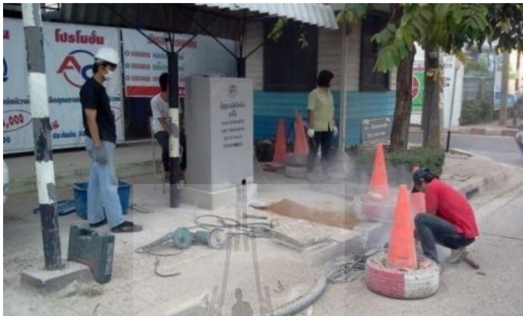
รูปที่ 3.25 การเดินสายไฟเข้าสู่ตู้ควบคุมระบบไฟจราจร (1)
