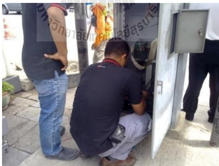
รูปที่ 3.32 การติดตั้งตู้ควบคุมสัญญาณไฟจราจรอัตโนมัติ (2)
