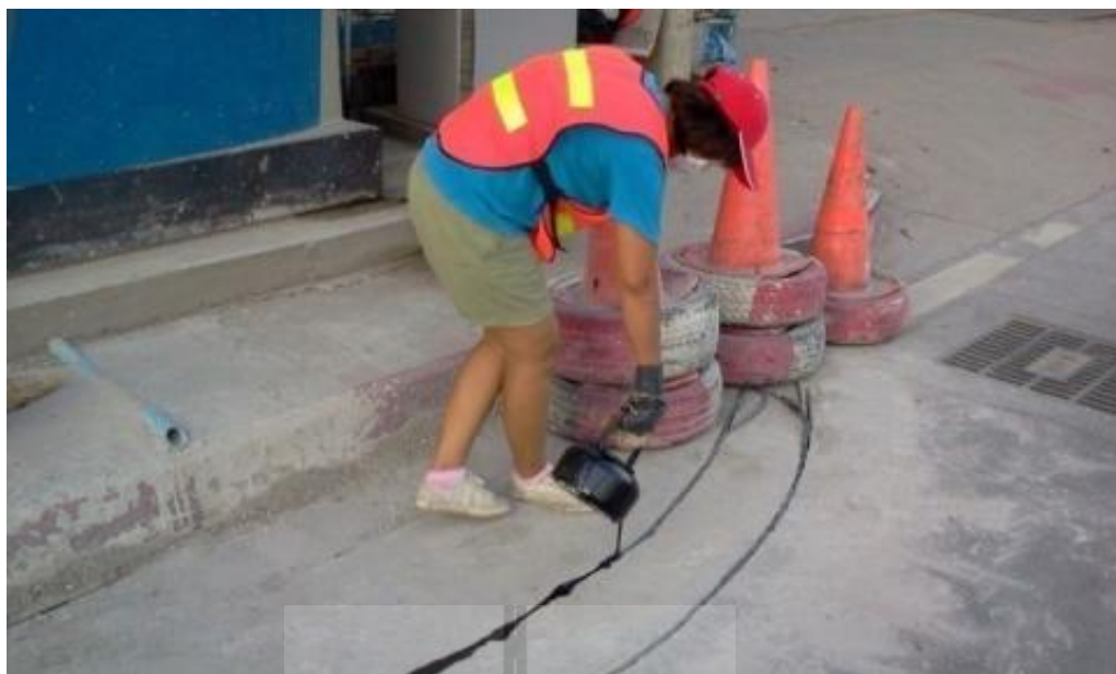
รูปที่ 3.21 การวางสายไฟและคืนสภาพพื้นผิวถนน (3)
