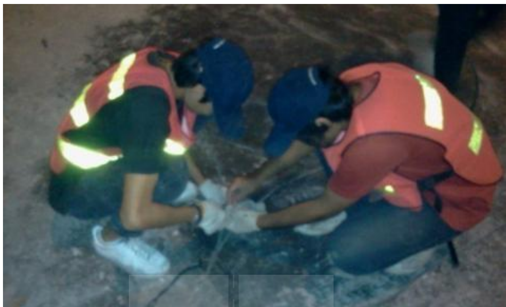
รูปที่ 3.23 การวางสายไฟและคืนสภาพพื้นผิวถนน (5)
