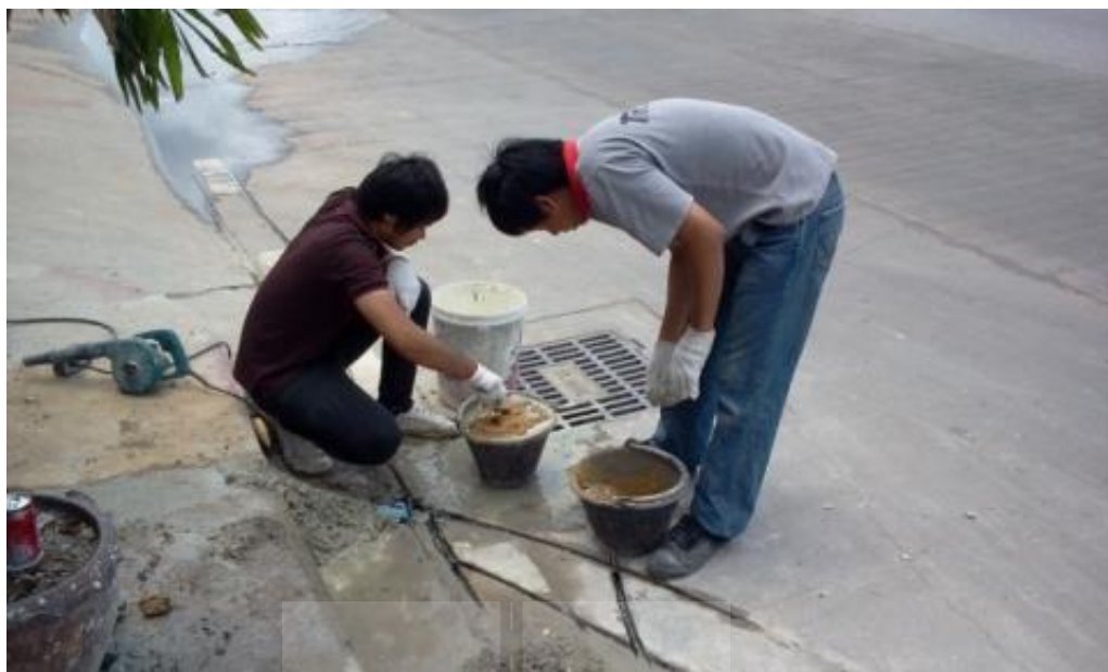
รูปที่ 3.29 การเดินสายไฟเข้าสู่ตู้ควบคุมระบบไฟจราจร (5)
