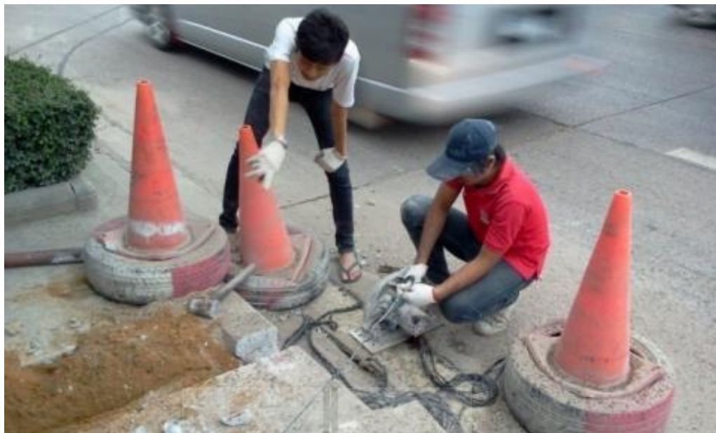
รูปที่ 3.27 การเดินสายไฟเข้าสู่ตู้ควบคุมระบบไฟจราจร (3)
