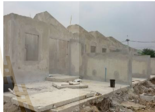
ง) ผนังที่เทคอนกรีตแล้วเสร็จ (Tunnel)
