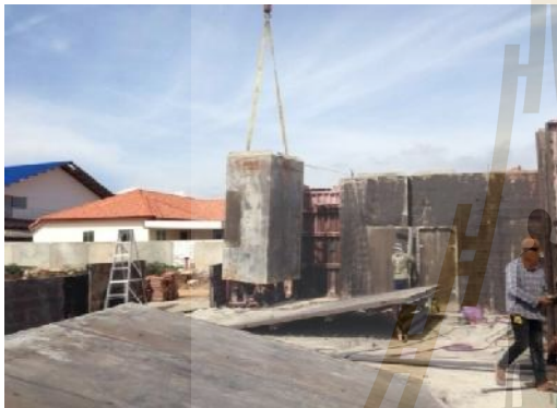
ค) ประกอบแบบหล่อเพื่อเทผนัง (Tunnel)
