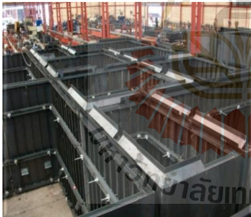
ก) แบบหล่อคอนกรีตชั้นที่ 1
