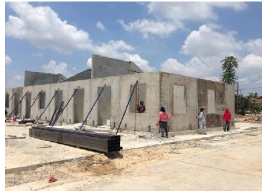
ข) นำผนังสำเร็จรูปมาติดตั้ง (Precast)
