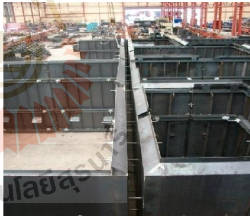
ข) แบบหล่อคอนกรีตชั้นที่ 2
