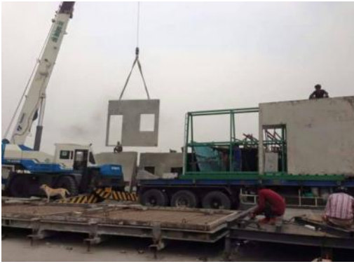
ก) ผลิตผนังสำเร็จรูปที่โรงงาน (Precast)
