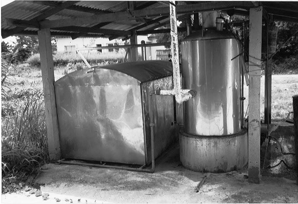
ภาพที่ 2 หม้อน้ำที่ใช้สำหรับมาเชื่อมก้อนเห็ด
