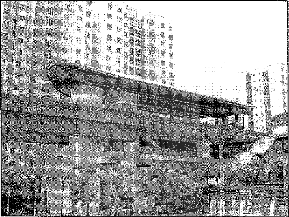
รูปที่ 5-5 สถานียกระดับแบบ Center Platform
