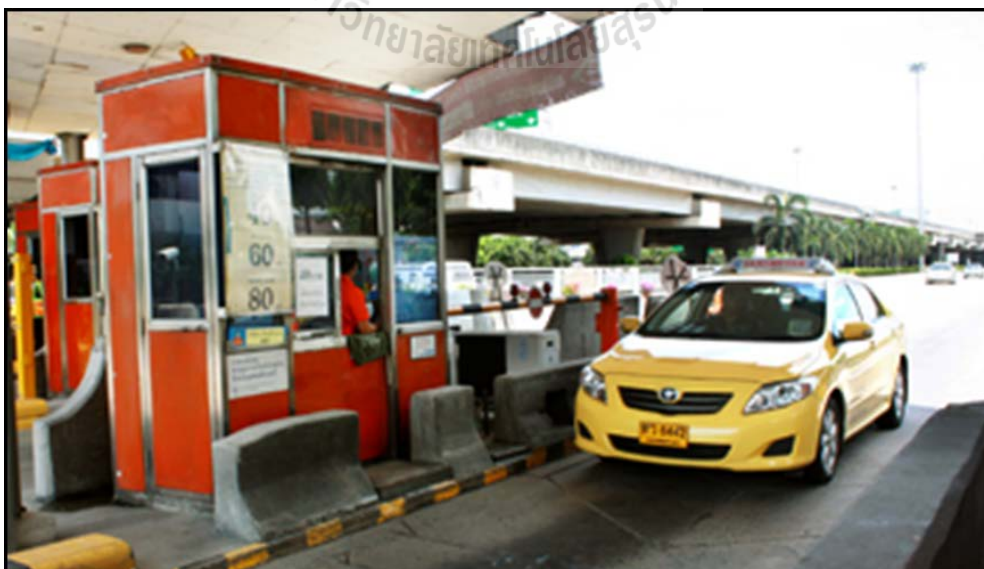
รูปที่ 2.3 ระบบเก็บค่าผ่านทางด้วยเงินสด (Manual Toll Collection)
