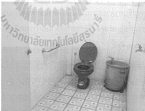
รูปที่ 22 ห้องน้ำในวัดที่มีการสร้างราวจับเพิ่ม
