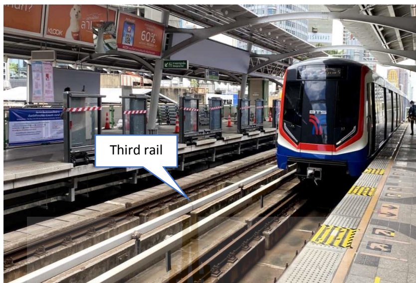
รูปที่ 2.9 รางที่สามในระบบขนส่งมวลชนกรุงเทพ
